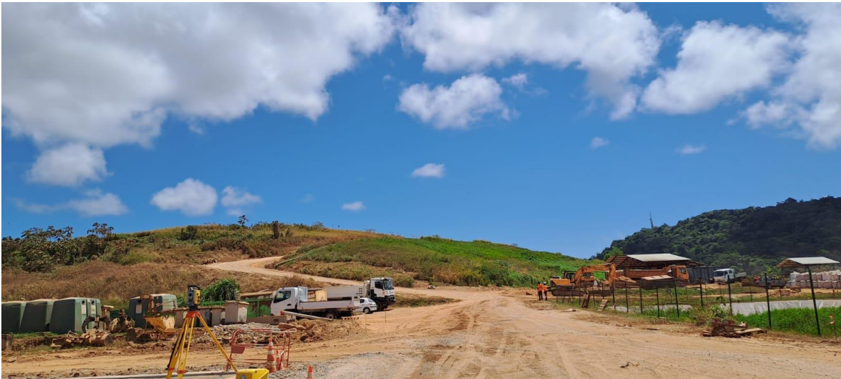
Photo : Dôme de l'ISDND des Maringouins
