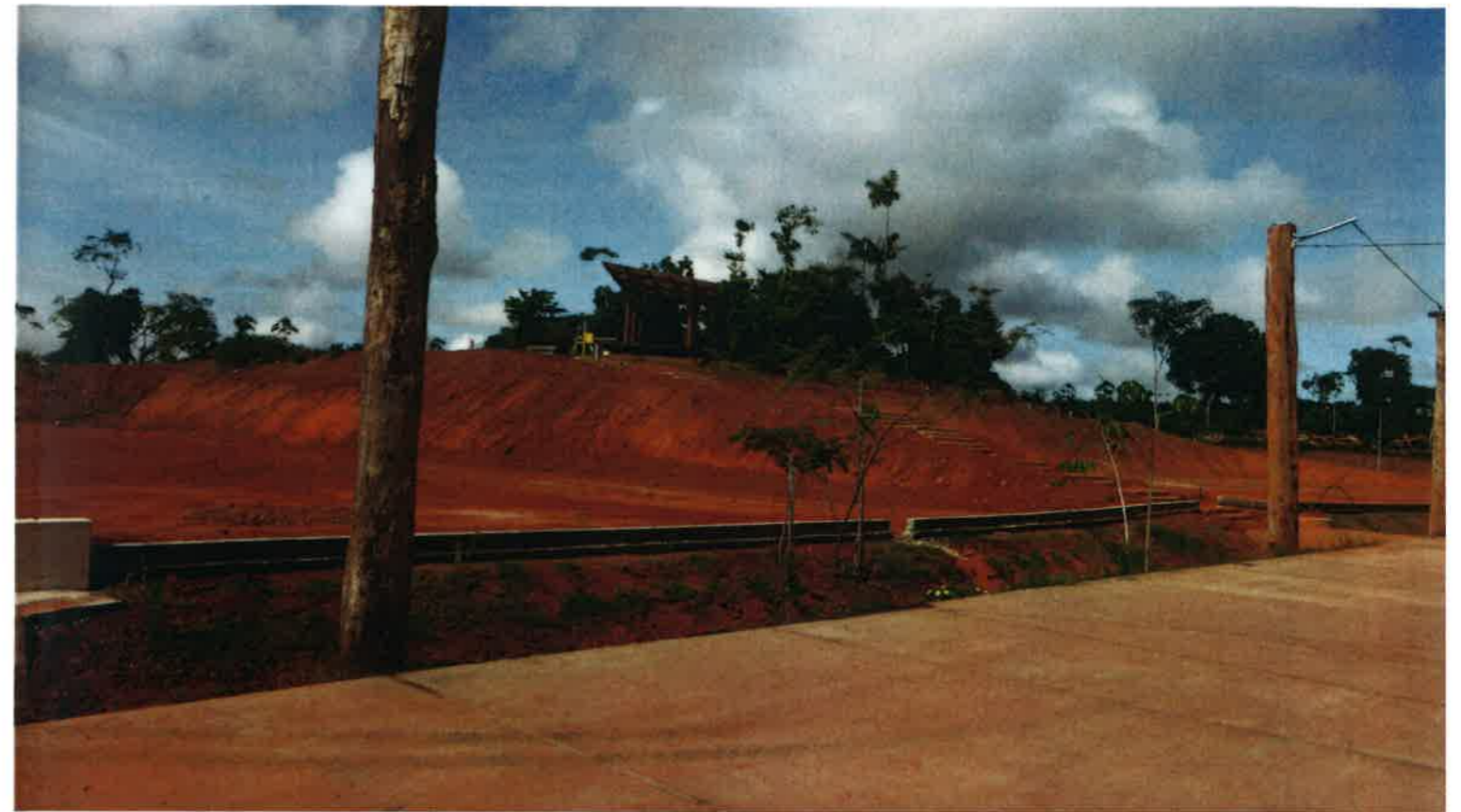
PC 7_Vue B : Vue depuis la placette vers le point de vue & carbet public
