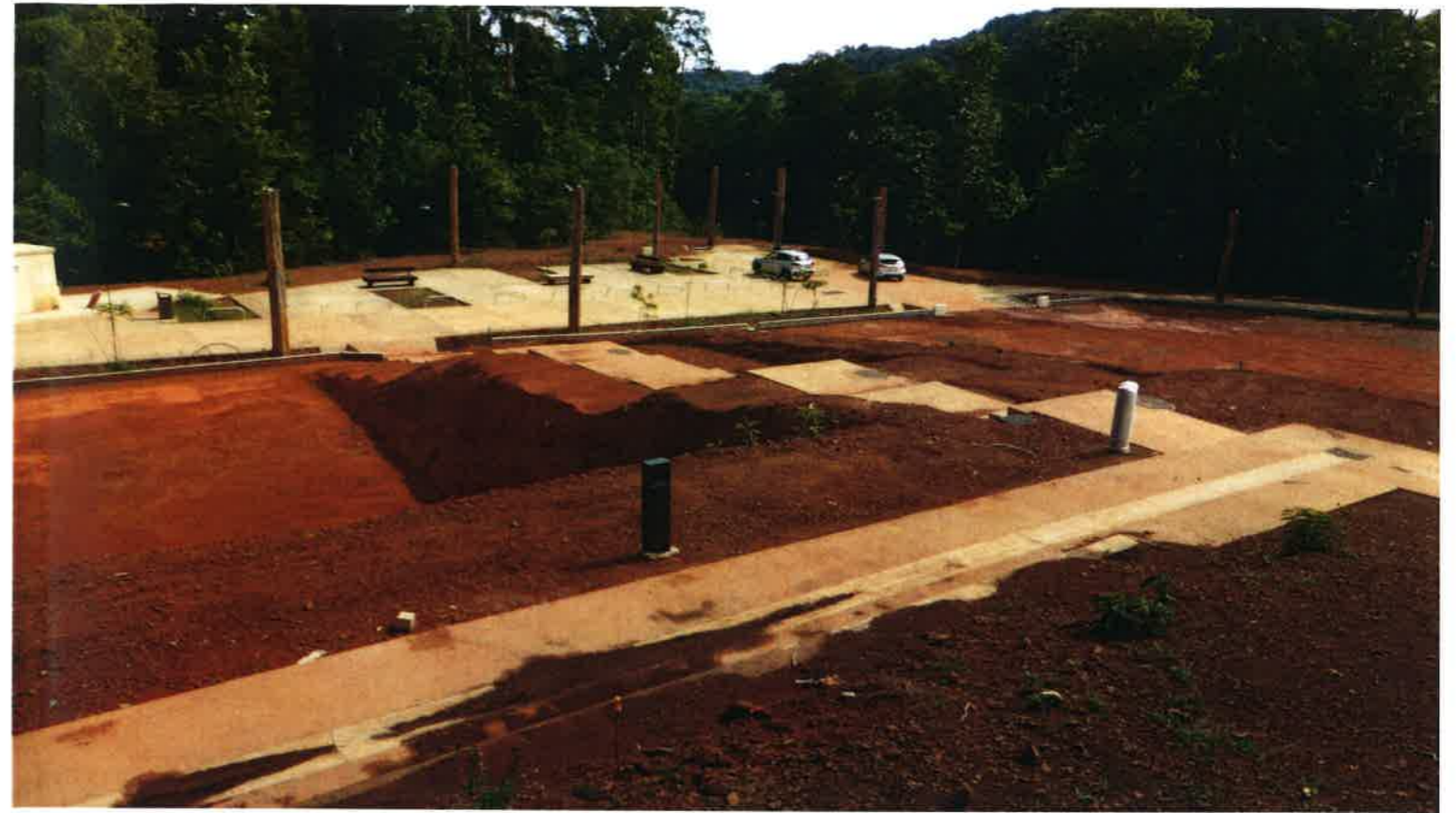
PC 8_Vue B : Vue d'ensemble depuis le point de vue & carbet (placette & forêt voisine)
